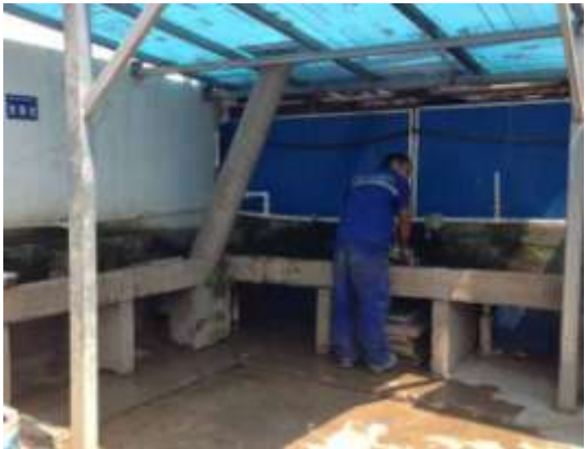
施工营地——洗漱台、地面截水槽
