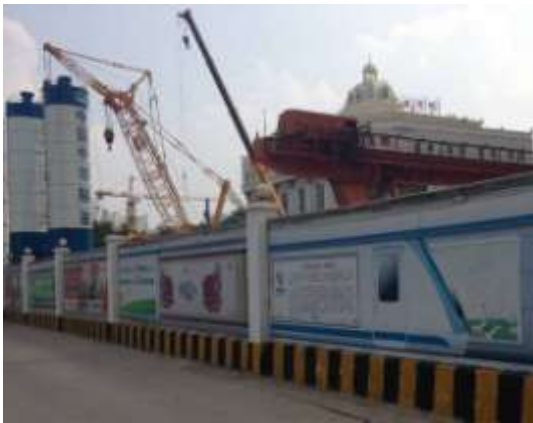
施工场地——外围挡墙
