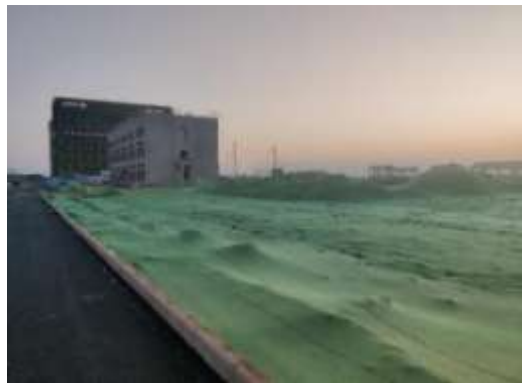
车辆段施工期裸土及砂石等散料防尘覆盖堆放
