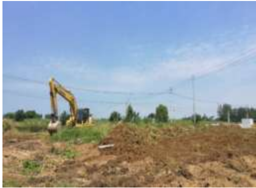
车辆段表土剥离和施工完成后植被恢复
