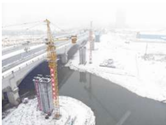
跨河柱墩完成
