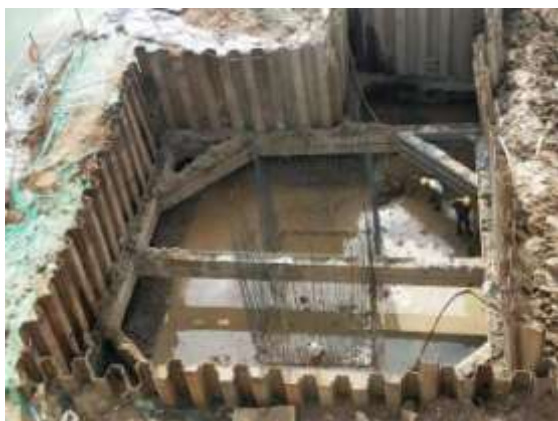
钢围堰施工
