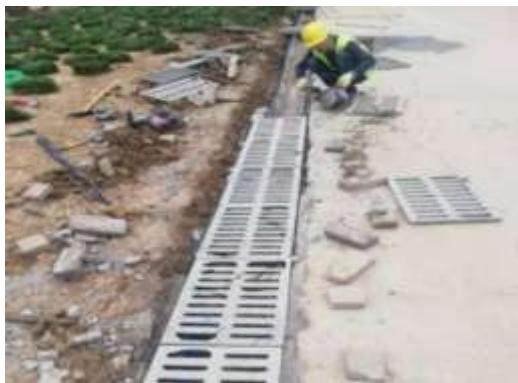
施工场地内截水沟修建和场地硬化
