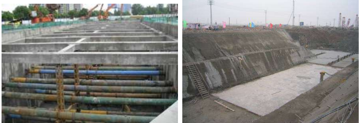
图 2.1-9 明挖法施工
