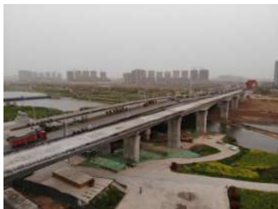
清清河特大桥主体完成后全貌
