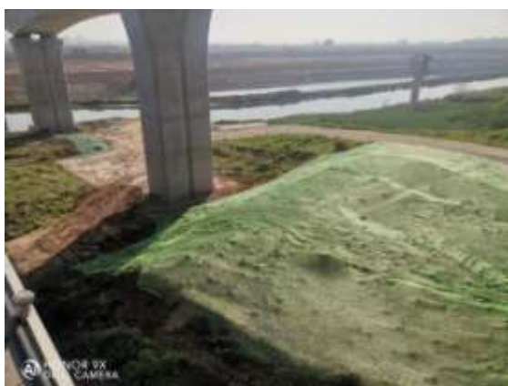
桥下回填及堆土覆盖
