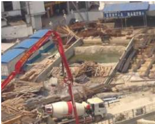
施工场地——废水沉淀池
