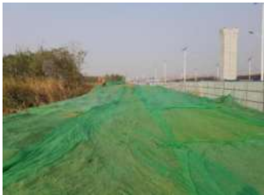
车辆段施工期裸土及砂石等散料防尘覆盖堆放
