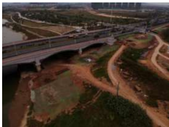
桩基承台施工
